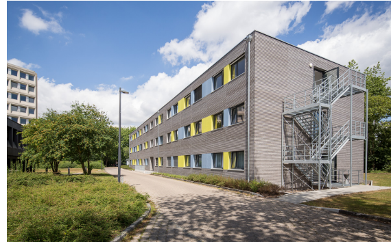
Aesthetic and functional: the DRV Verwaltungsgebäude in Münster wood exteriors and steel fire escape (© ERNE AG Holzbau | photograph: Jan Meier, Bremen)
