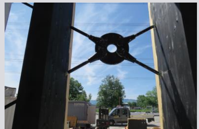
Knotenpunkt der Stahlstreben für die Wandaussteifung
