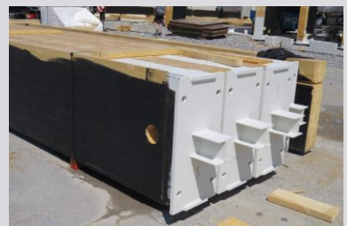
Fußdetail der tragenden Brettschichtholzstützen der Außenseite
