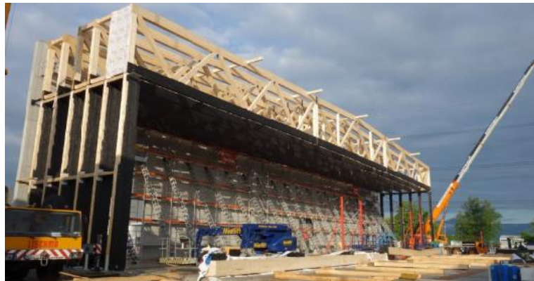
Die Hallen entstehen: 66 m Spannweite ohne Stützen in der Mitte (Foto: Messe Dornbirn GmbH)
