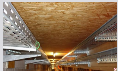
Installationsschächte an der Unterseite der Dachelemente
