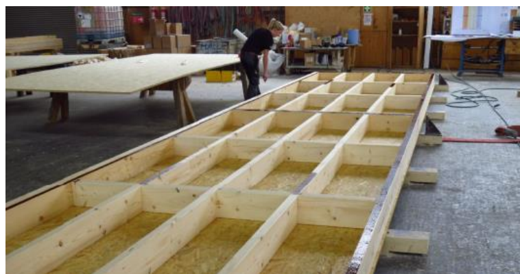
Vorfertigung der Kastenelemente mit SWISS KRONO OSB/3 EN300 im Werk von Kaufmann Bausysteme (Foto: SWISS KRONO GmbH)
