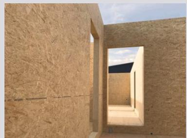
Ohne Bepunktung mit Gipswerkstoffplatten werden die **MAGNUMBOARD® OSB**-Oberflächen direkt beschichtet
