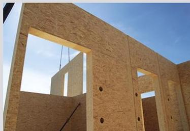
Vorgefertigte Elemente für Innen- und Außenwände mit Aussparungen für Fenster und Installationen
