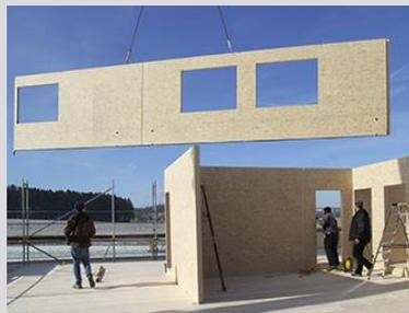
Großformatige, fugenlose Elemente beschleunigen die Montage
