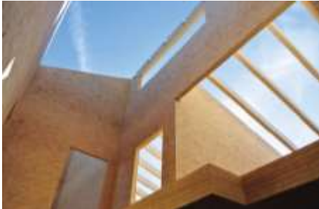
Schneller Baufortschritt mit vorgefertigtem SWISS KRONO MAGNUMBOARD ® OSB (Bildnachweis: BALAZS Komforthaus GmbH)
