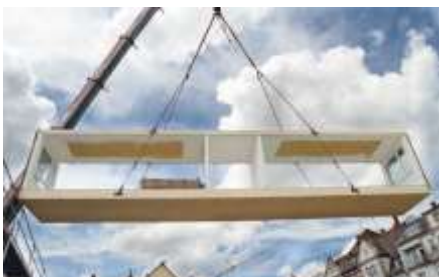
Montage der Holzmodule auf der Baustelle in Nürnberg (Bildnachweis: ERNE AG Holzbau | Fotos: www.rosengruen.de )
