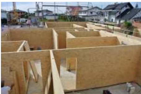
Rasche Montage der vorgefertigten SWISS KRONO MAGNUMBOARD® OSB Elemente (Bildnachweis: BALAZS Komforthaus GmbH)
