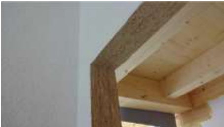
Direkte Beschichtung von SWISS KRONO MAGNUMBOARD ® OSB mit Farbe (Bildnachweis: Henri VERMOT et Fils Sàr | Foto: SWISS KRONO GmbH)
