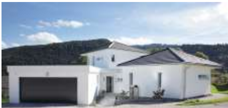
Einfamilienhaus, das mit SWISS KRONO MAGNUMBOARD ® OSB errichtet wurde (Bildnachweis: Henri VERMOT et Fils Sàr)
