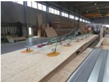
Vorfertigung von Boden- und Deckenelementen mit SWISS KRONO LONGBOARD OSB (Bildnachweis: ERNE AG Holzbau)
