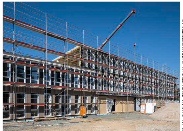
▲ Das Schulgebäude des Campus entsteht
