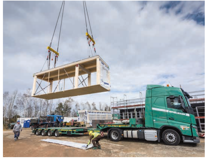
▲ Per Lkw werden die vorgefertigten Module angeliefert
