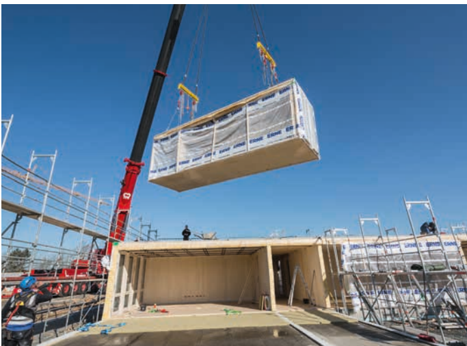
▲ Aus einzelnen Holzbaumodulen entstehen Klassenräume
