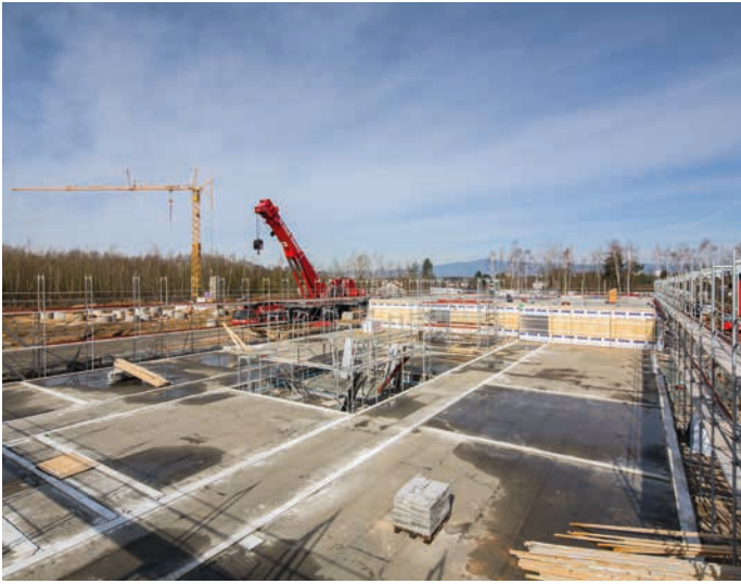
▲ Großbaustelle Schulneubau in Holz-Modulbauweise
