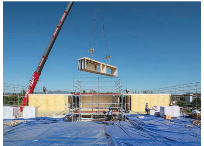
▲ Modul um Modul wird das Gymnasium errichtet
