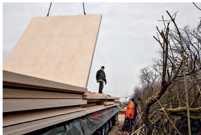
Anlieferung der vorgefertigten „Magnumboard® OSB“ Elemente mit dem LKW und Krantransport (Fotos: Swiss Krono)
