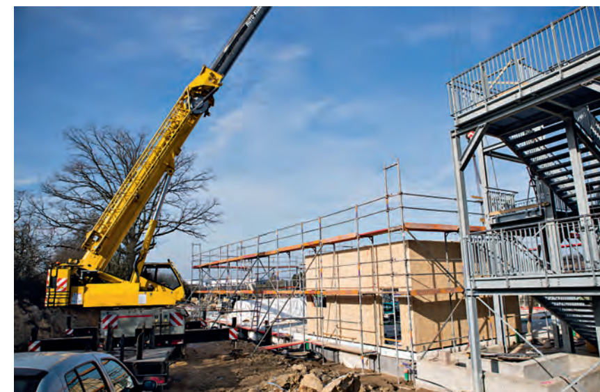
Gebäude aus Holz und Holzwerkstoffen neben der Stahltreppe zum Skywalk
