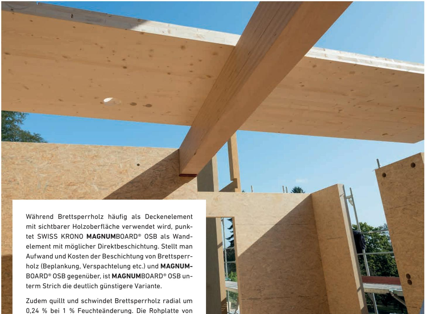
Während Brettsperrholz häufig als Deckenelement mit sichtbarer Holzoberfläche verwendet wird, punktet SWISS KRONO **MAGNUMBOARD® OSB** als Wandelement mit möglicher Direktbeschichtung. Stellt man Aufwand und Kosten der Beschichtung von Brettsperrholz (Beplankung, Verspachtelung etc.) und **MAGNUMBOARD® OSB** gegenüber, ist **MAGNUMBOARD® OSB** unter Strich die deutlich günstigere Variante.
