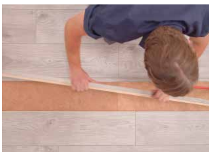
Уход и ремонт
