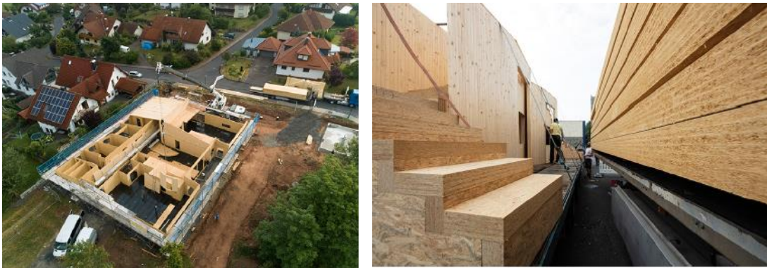
Links: Die Baustelle aus Vogelperspektive. Rechts: Anlieferung vorgefertigter Elemente für die Kindertagesstätte (Bildnachweis: © SWISS KRONO | Foto: tm studios)
