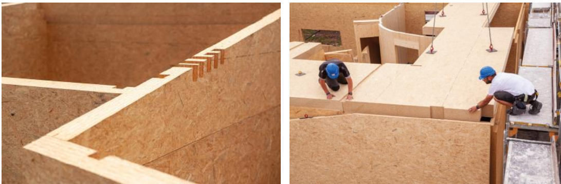
Präzise vorgefertigte Elemente aus SWISS KRONO MAGNUMBOARD® OSB werden fachmännisch montiert (Bildnachweis: © SWISS KRONO | Foto: tm studios)
