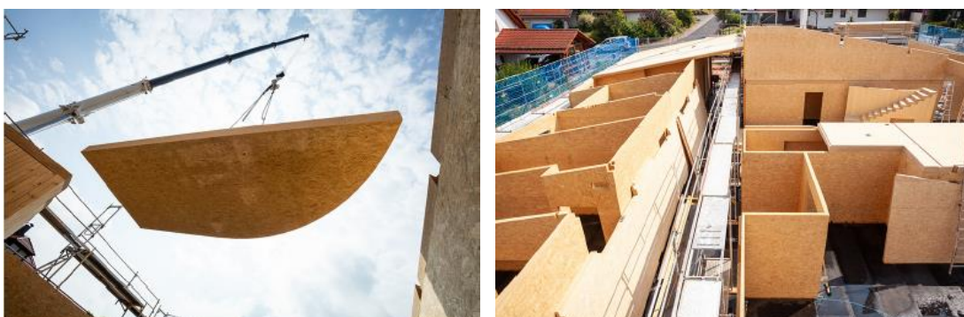
Exakt zugeschnittene Elemente werden per Kran an die richtige Position gebracht und fachmännisch montiert (Bildnachweis: © SWISS KRONO | Foto: tm studios)
