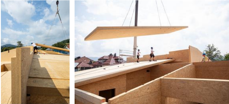
Wände und Decken aus großformatigen Elementen werden schnell montiert (Bildnachweis: © SWISS KRONO | Foto: tm studios)
